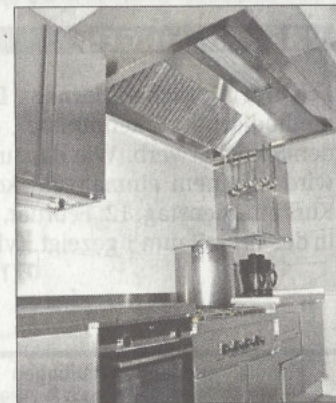
Das Herzstück der Sanierung ist die neue Küche. FOTOS: BIMEK
