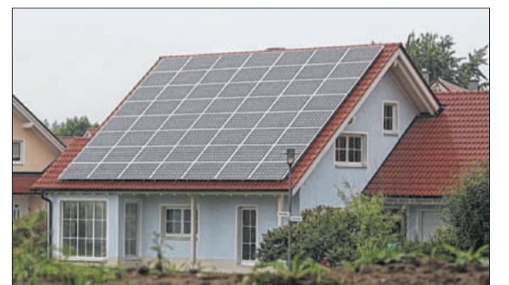
Mit Photovoltaik auf dem Dach wird der Verbraucher zum Selbstversorger.
